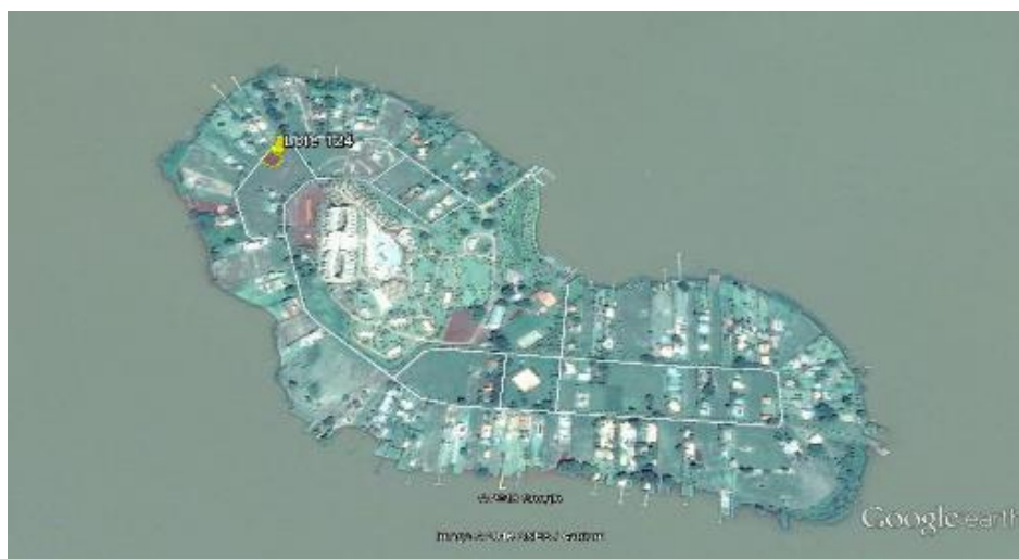
Detalhes Gerais do Condomínio
