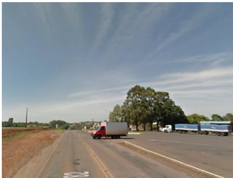
Detalhes do acesso
