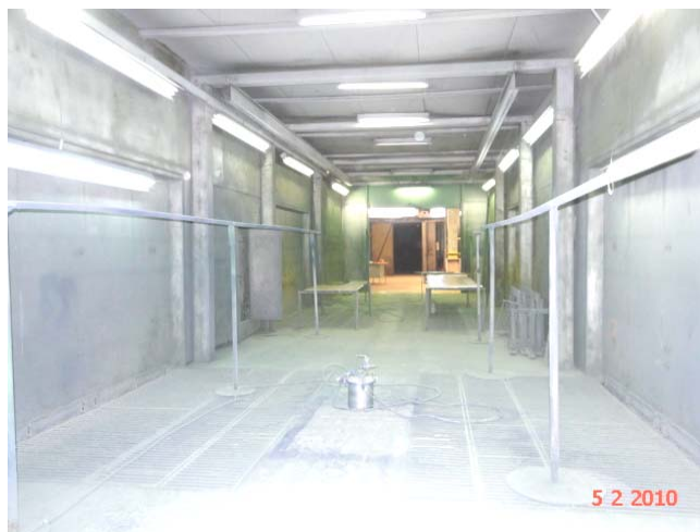
ITEM 87 – CABINE DE PINTURA
